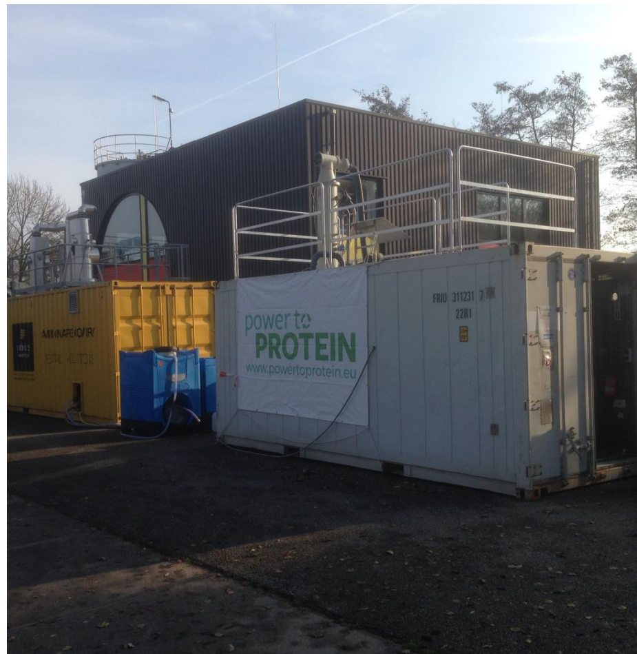
Proefinstallatie Power to Protein op de rwzi Horstermeer
