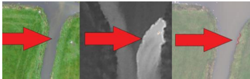
De afkalving is zichtbaar via een thermische infraroodcamera. De linker foto toont de originele situatie, de middelste laat het talud zien en uitstromend warm water en het ontstaan van de afkalving. In de rechter foto is de afkalving te zien.
