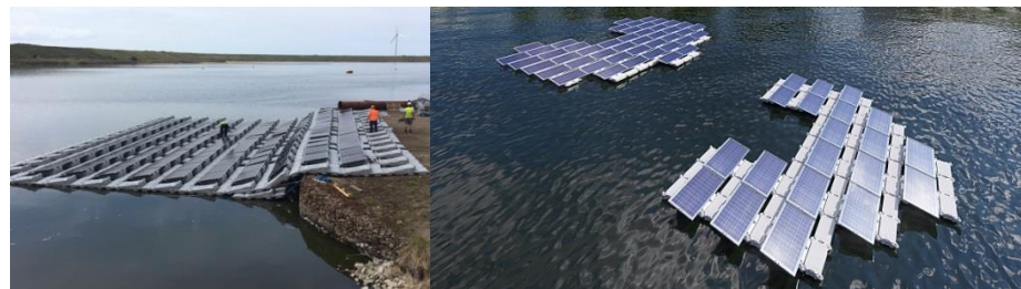
Aanleg van een drijvend PV-systeem Drijvende zonnepanelen
