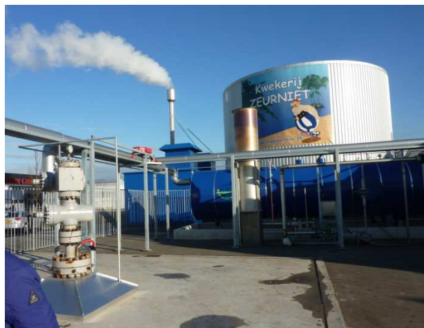
Links op de foto de aardwarmtebron van Kwekerij Zeurniet. In de blauwe tank wordt het methaangas afgescheiden (100 m 3 / uur). Op de achtergrond rookpluim van de WKK voor de elektravoorziening onder andere nodig voor aandrijving pompen en belichting.
